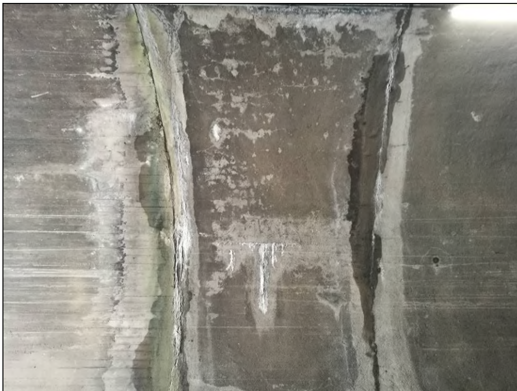
Obr. č. 4 - pohled na betonovou klenbu nad kamennou spodní stavbou, vlevo viditelná první dilatační spára s průsaky, vpravo od ní trhlina s průsaky
