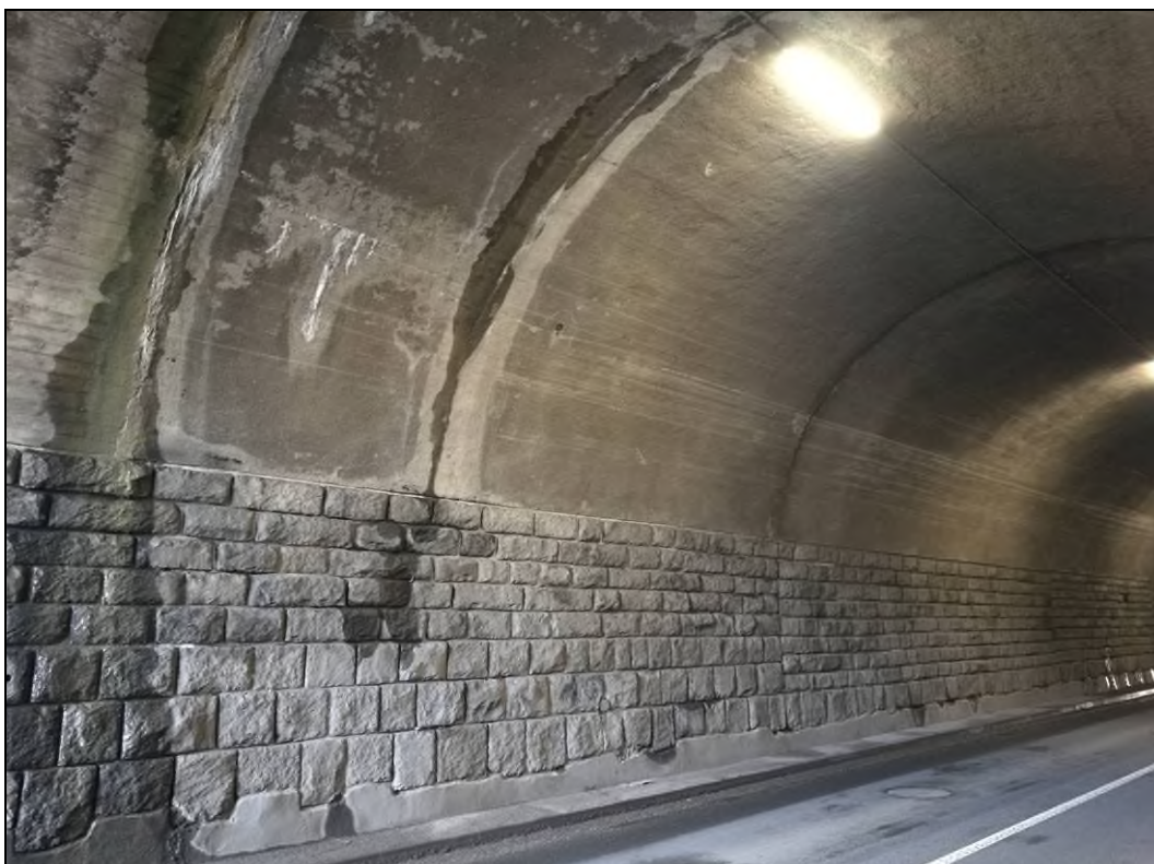
Obr. č. 7 - pohled na opěru Č. Třebová - v lici SS řádkové kamenné zdivo, betonová NK s průsaky
