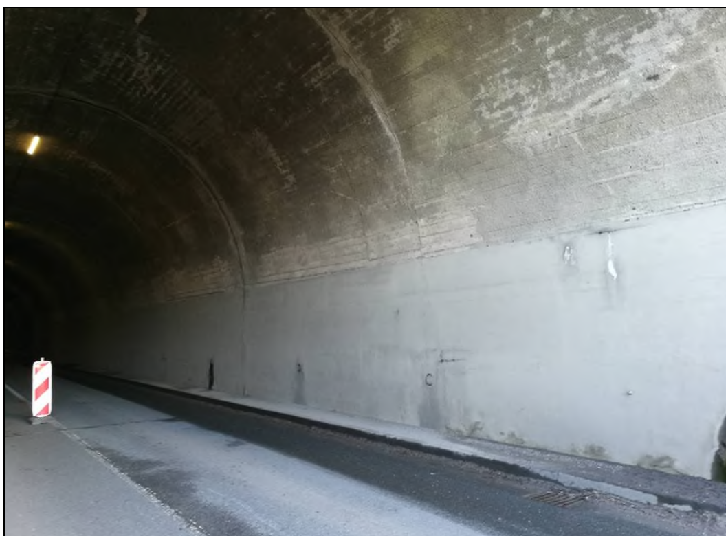
Obr. č. 9 - pohled na opěru Č. Třebová - betonová spodní stavba v líci pevná a bez poruch
