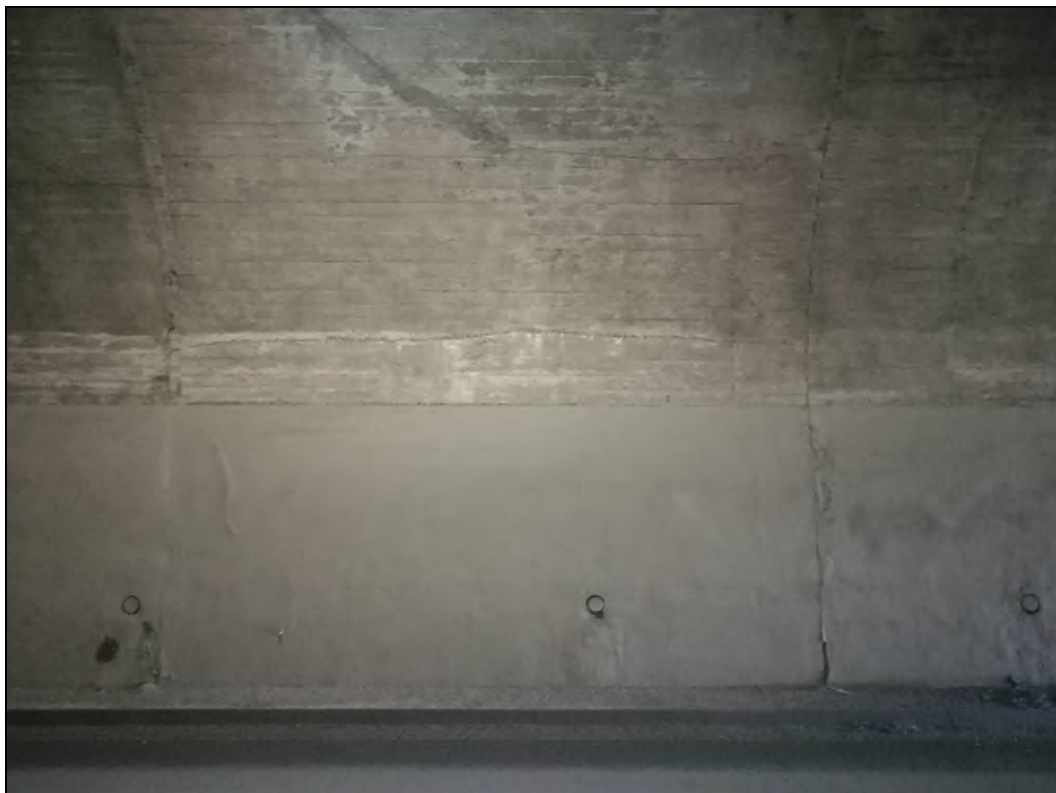
Obr. č. 10 - pohled na líc betonové SS a betonové NK v líci s viditelnými otisky bednění
